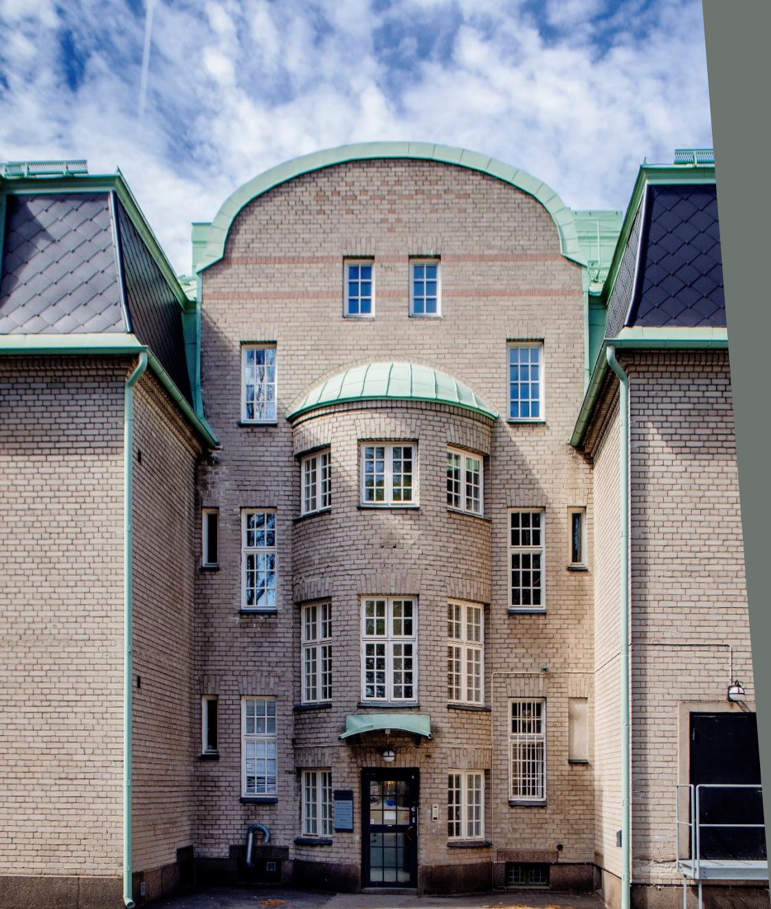
Kyllhuset 15, fd bostadshus för maskinister och förmän
